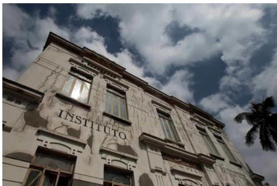
Prédio histórico do Instituto Butantan. Foto: Rafael Arbex/Estadão
